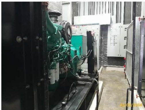
เครื่องกำเนิดไฟฟ้า ขนาด 400 KVA จำนวน 1 ชุด
